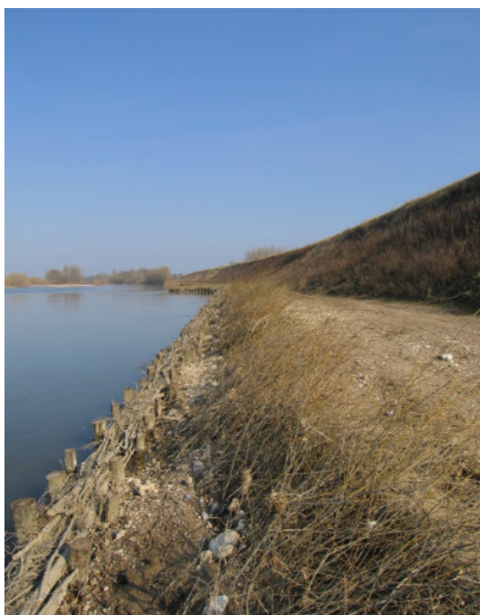
Travaux sur les digues de Loire
